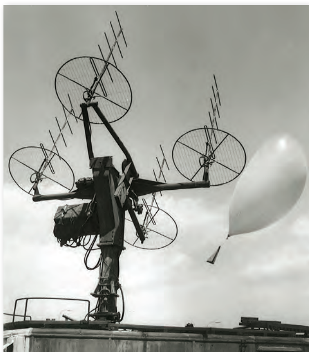
Radioteodolit MALACHIT – anténní systém
