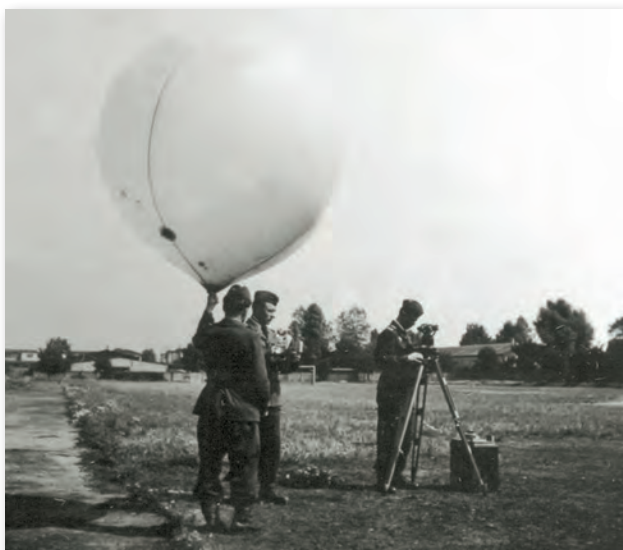
Příprava výškového měření pomocí jednopilotáže v 50. letech
