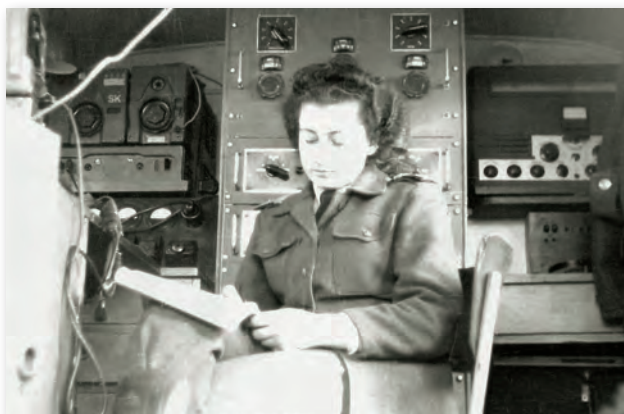
Radiotelegrafistka pojízdné letecké meteorologické stanice LPS-58, zleva rádiové prostředky LR-10, PELIKÁN P-52 a Lambda 4
