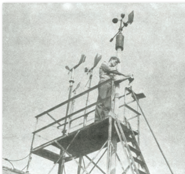
Plošina školní povětrnostní stanice s čidly větroměrných systémů
